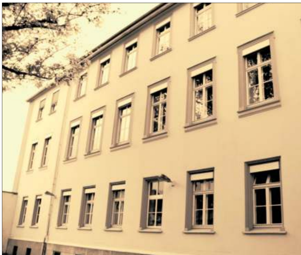
Im Gebäude an der Kampstraße befand sich im Zweiten Weltkrieg das Mindener Amtsgericht. Vor dem Untersuchungsgefängnis mussten sich die Deportierten versammeln. MT-Foto: Stefan Koch
