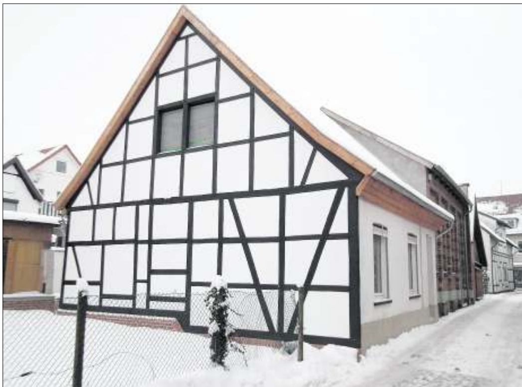
Das Gebäude der alten jüdischen Schule an der ehemaligen Synagoge in Petershagen ist von außen saniert. Im Inneren stehen jedoch noch einige Arbeiten an. Hierfür stellt die NRW-Stiftung weiteres Geld zur Verfügung. MT-Foto. Uwe Vinke
